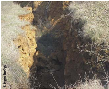
Crevasse suite à un mouvement. Affaissement différentiel.
