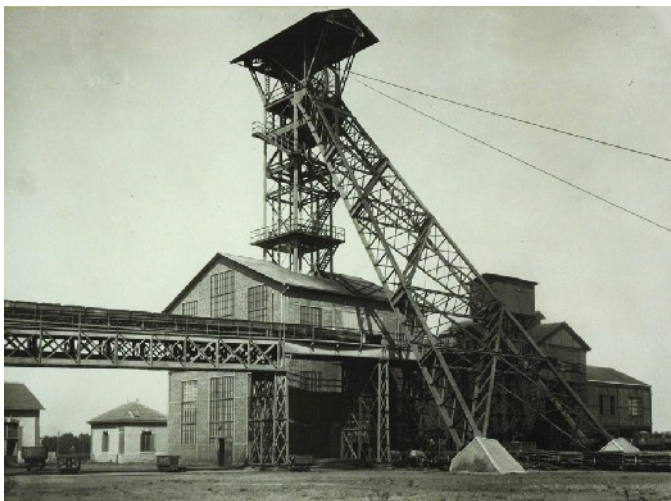
Société des mines de houille de Blanzay (Saône-et-Loire), siège Magny, puits Laugerette, 1927 : tirage photographique. Archives nationales - CAMT (cote 92 AQ 33).
